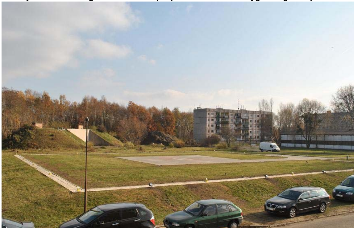
Fot. 23 Lądowisko dla śmigłowców sanitarnych po stronie wschodniej głównego budynku WSS
