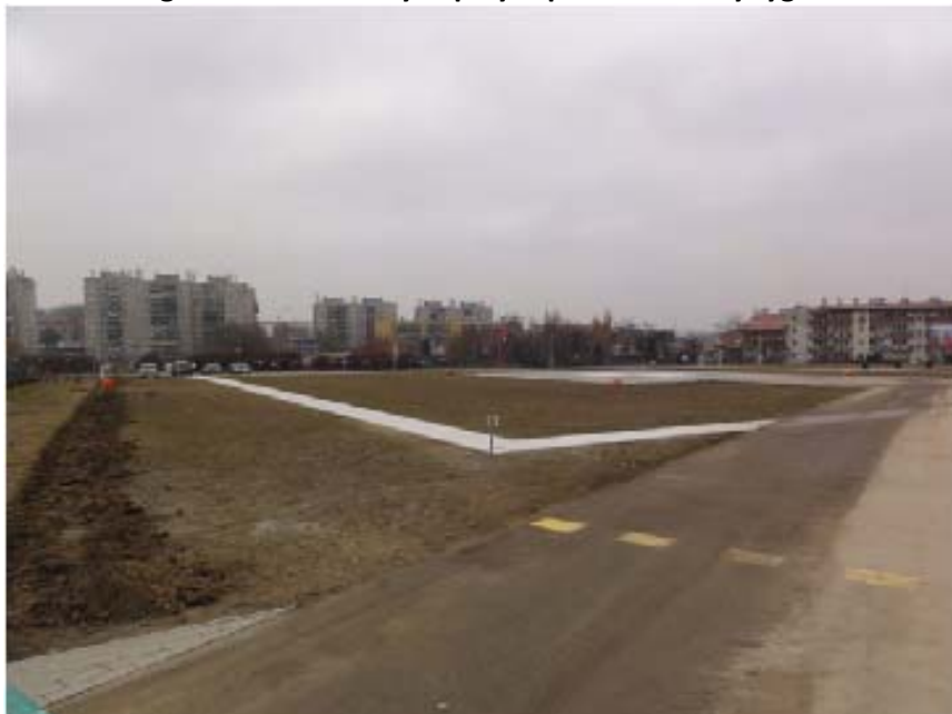
Fot. 21 Lądowisko dla śmigłowców sanitarnych przy Szpitalu im. L. Rydygiera w Krakowie
