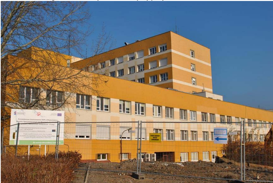
Fot. 22 Budynek Wojewódzkiego Specjalistycznego Szpitala we Wrocławiu od strony Szpitalnego Oddziału Ratunkowego. W tle roboty budowlane przy podjeździe dla ambulansów.
